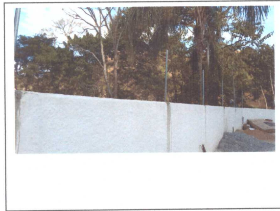
Montante para instalação do alambrado
