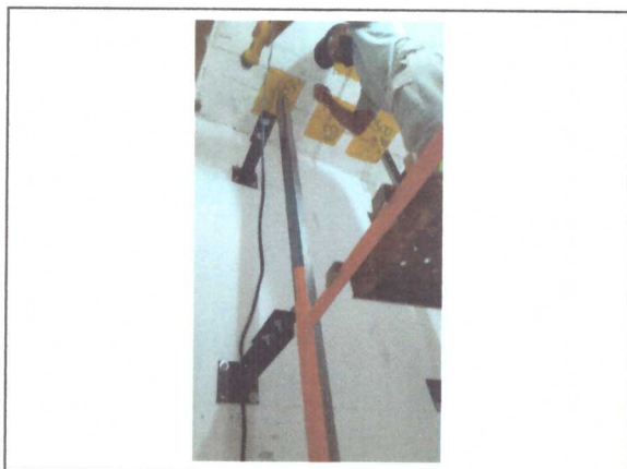
Instalação do elevador
