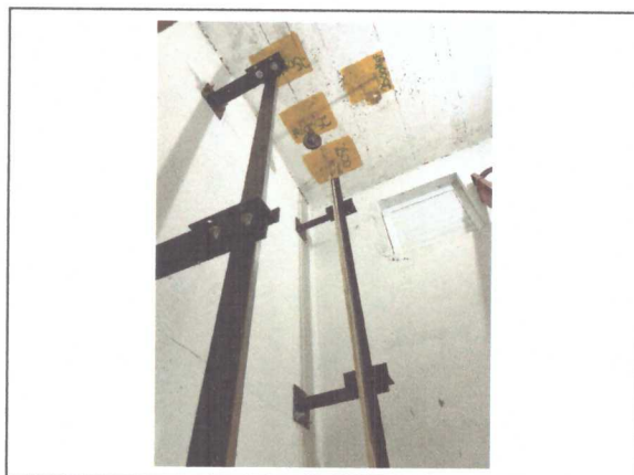
Instalação do elevador
