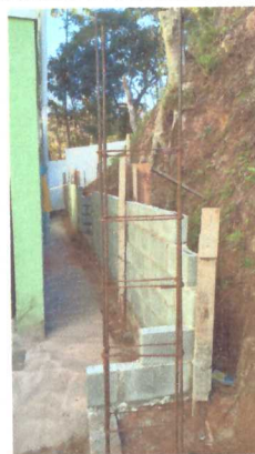
Assentamento de alvenaria
