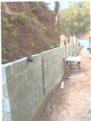
Assentamento de alvenaria
