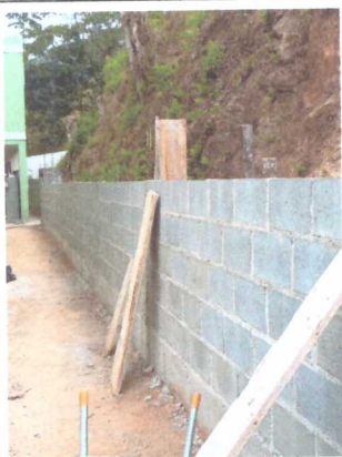
Assentamento de alvenaria
