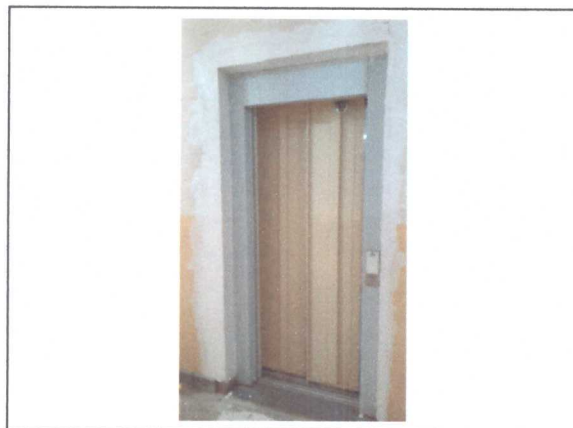
Instalação do elevador
