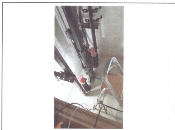
Instalação do elevador
