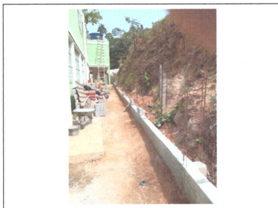
Viga baldrame concretada
