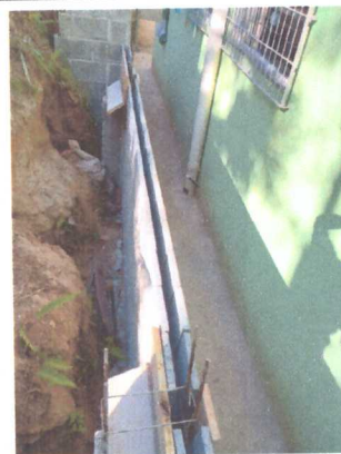
Execução de viga de travamento do muro
