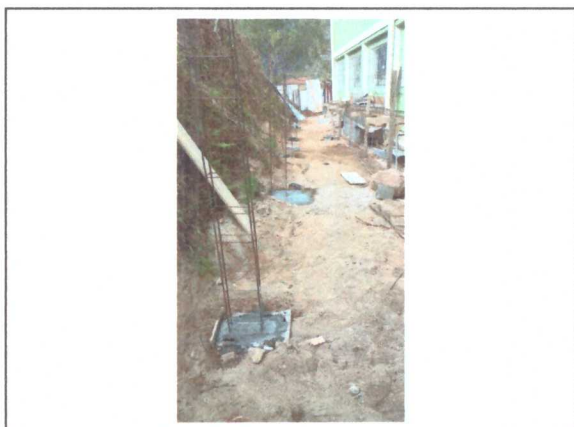
Concretagem das sapatas
