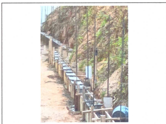
Concretagem da viga baldrame
