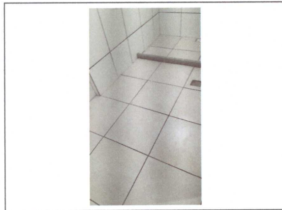
Assentamento de revestimento
