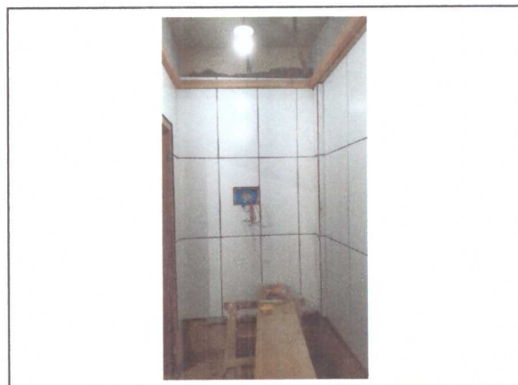
Assentamento de revestimento
