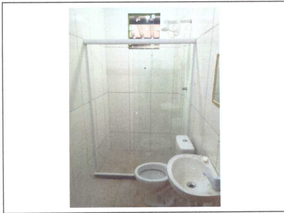
Vaso, Box, Pia e chuveiro instalados
